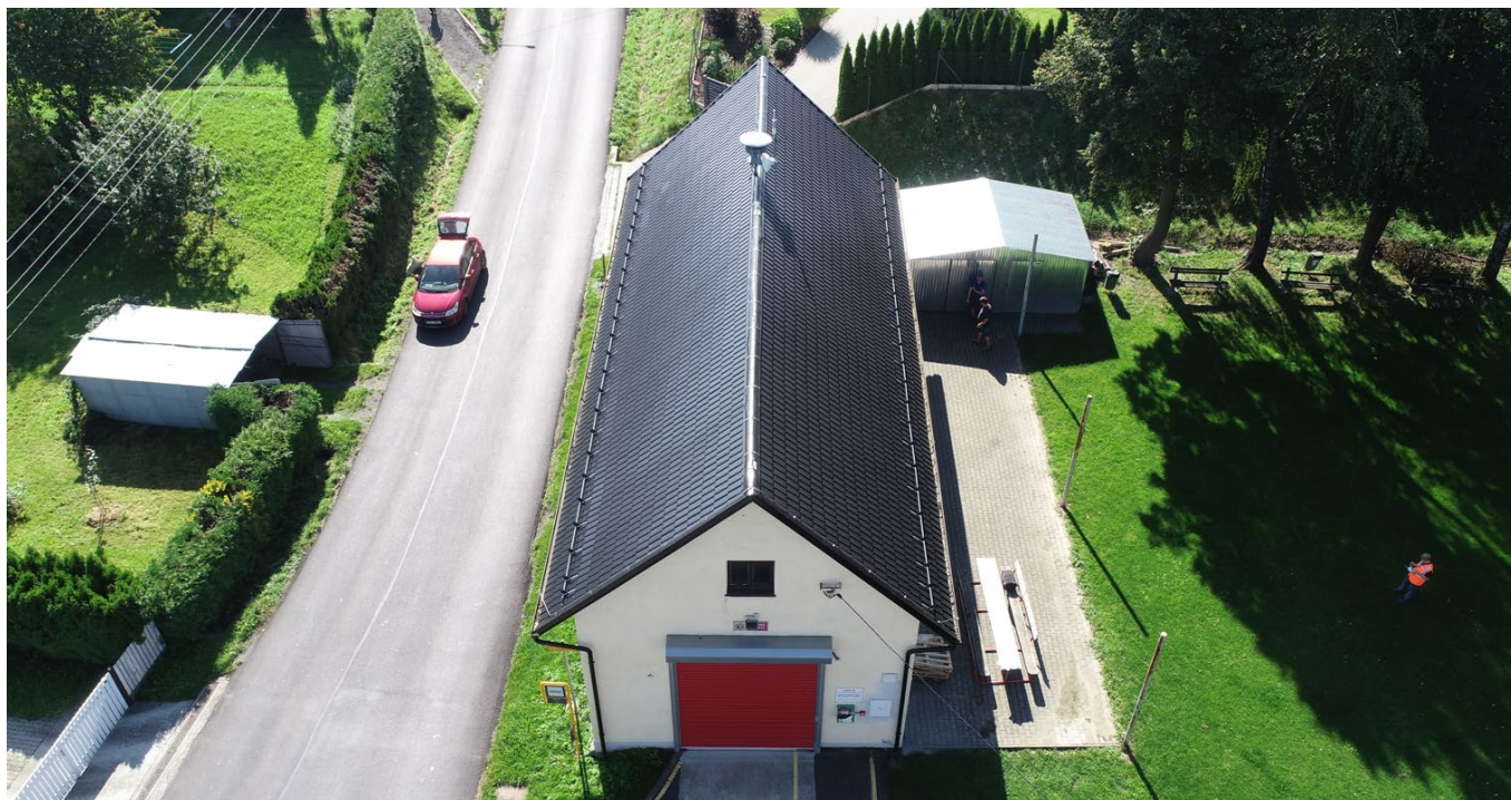
Obrázek 1 – Střeška objektu „Hasičárna“ Obce Vražné ve Vražném
